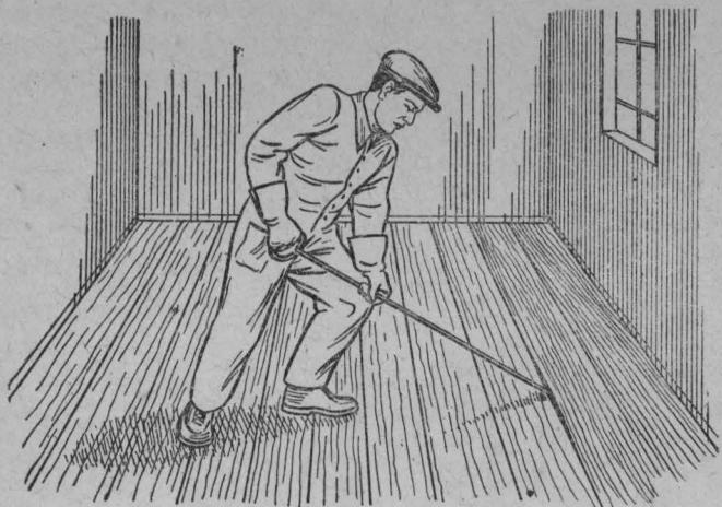
Рис. 4. Вскрытие пола ломом.
