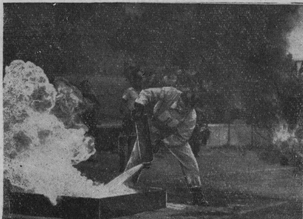
Рис. 32. Тушение горячей жидкости в противне огнетушителем.
