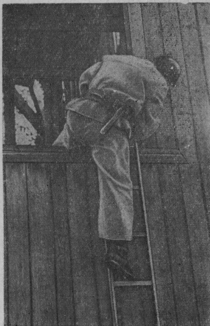
Рис. 10, а и б. Выход с лестницы в окно для посадки на подоконник.
