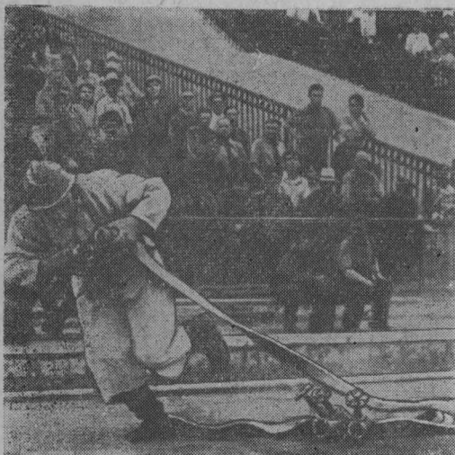
Рис. 20. Присоединение ствола к рукавной линии.
