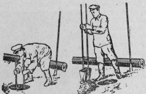
Рис. 56. Рытьё ям при помощи ковша-лопаты
