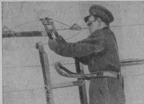
Рис. 64. Термитная сварка проводов с лестницы
