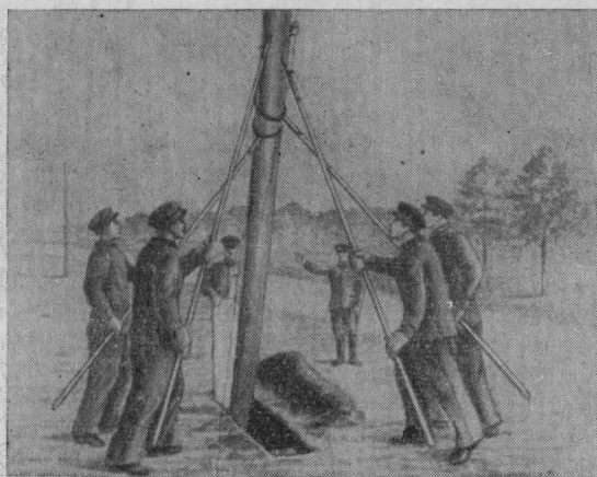
Рис. 57. Установка опор: при помощи ручной лебёдки и старой опоры (вверху), вручную (внизу)
