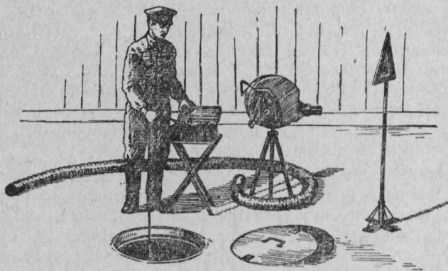
Рис. 66. Проверка отсутствия газов в кабельном колодце
