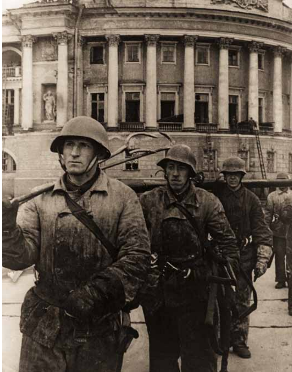
Пожарные городской пожарной части спешат на пожар, возникший в здании бывшего Сената, вследствие попадания 8-ми дюймового снаряда. Ленинград. 18 сентября 1941 г.
