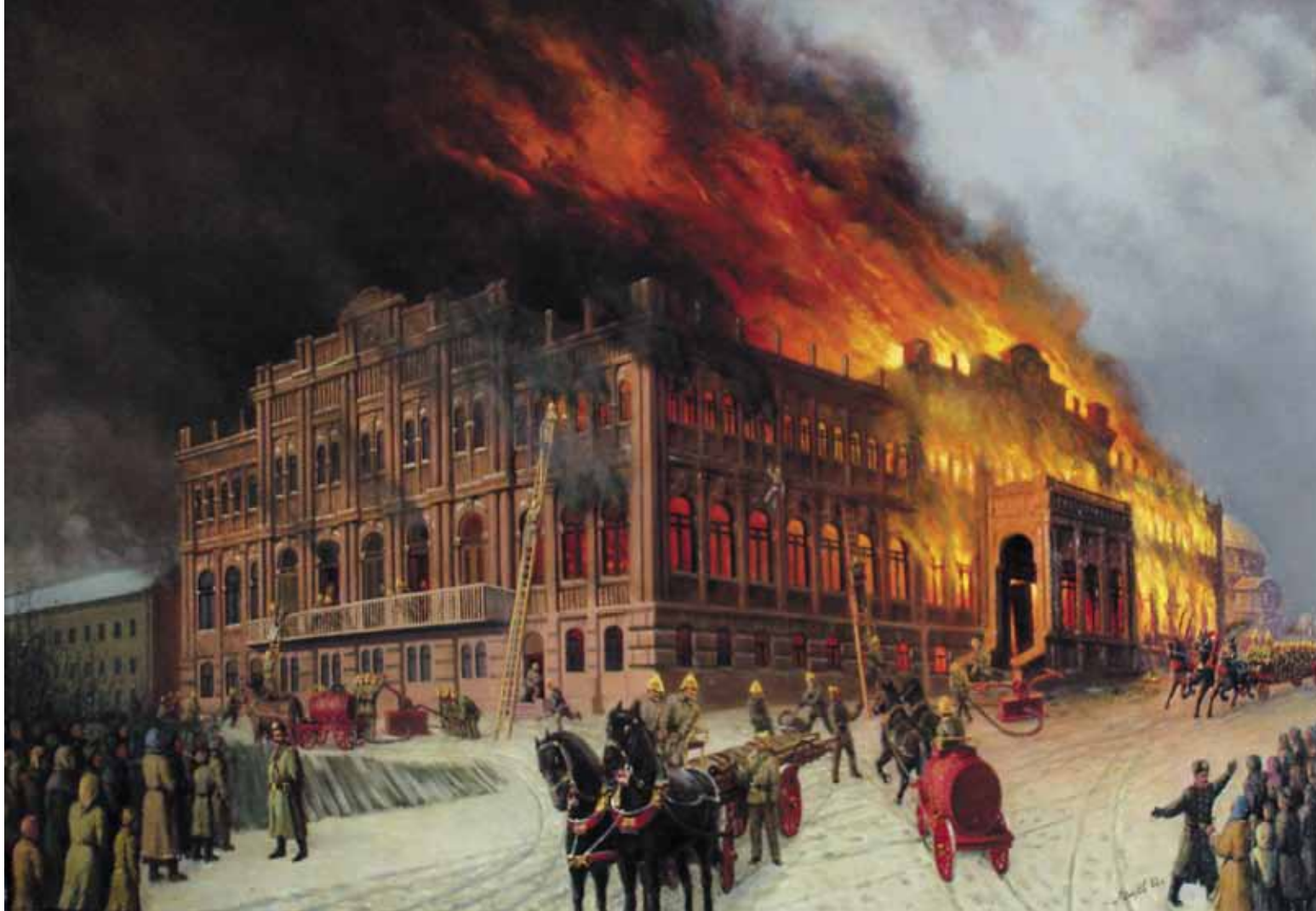
В.В. Лещев. Пожар здания дворянского собрания в г. Курске 17-19 октября 1892 г. V.V. Leshchev. A fire of noble assembly building in Kursk from the 17th to the 19th of October, 1892
