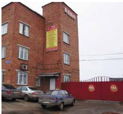
Здание Коми республиканского отделения ВДПО в настоящее время
