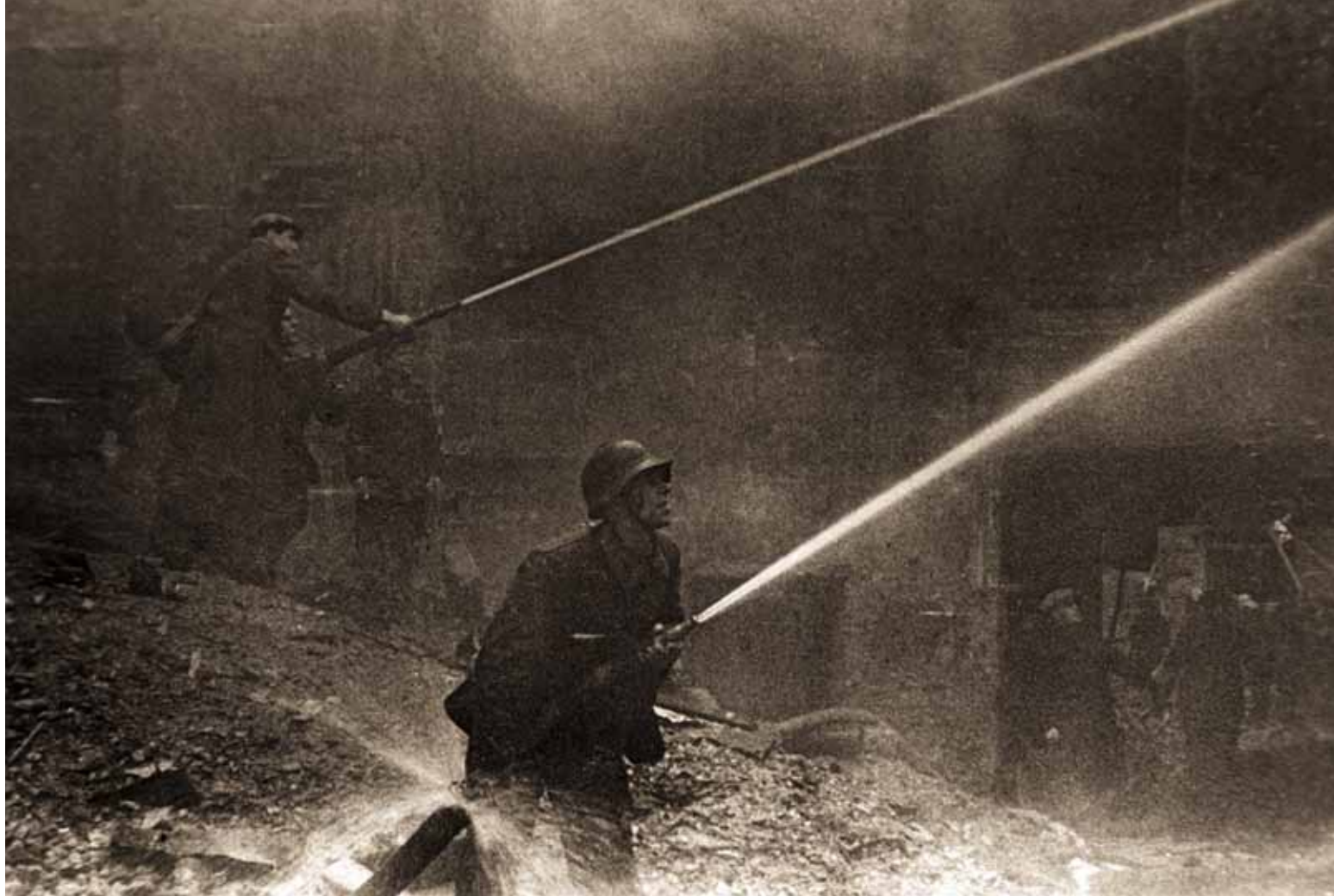
Тушение пожара в Дмитровском переулке. Ленинград. 19 сентября 1941 г. A fire extinguishing in Dmitrovskiy lane. Leningrad. The 19th of September, 1941
