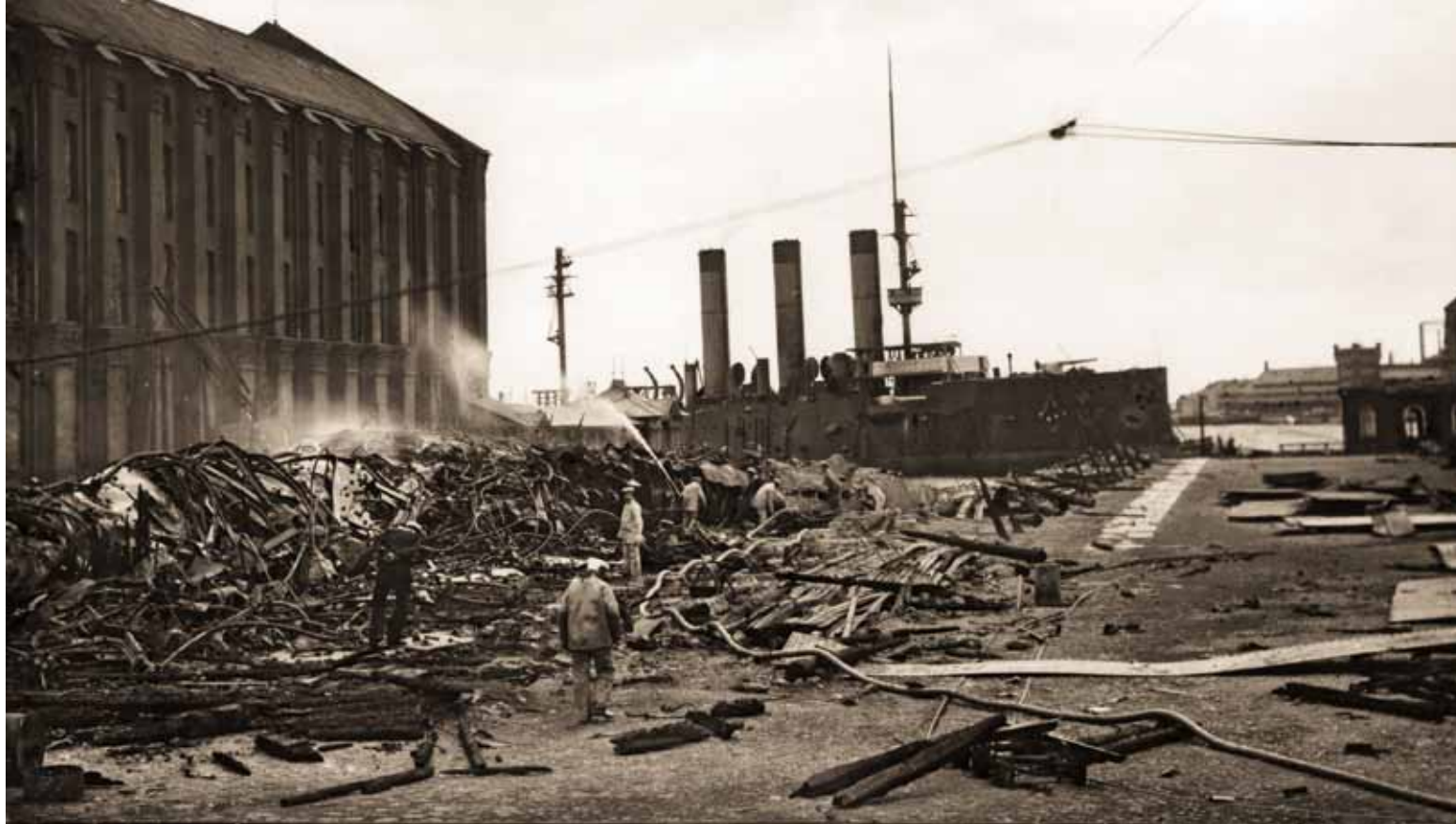
Пожарные Казанской части на тушении пожара. Санкт-Петербург. До 1914 г. Kazan fire station firemen are extinguishing. Saint-Petersburg. Before 1914
