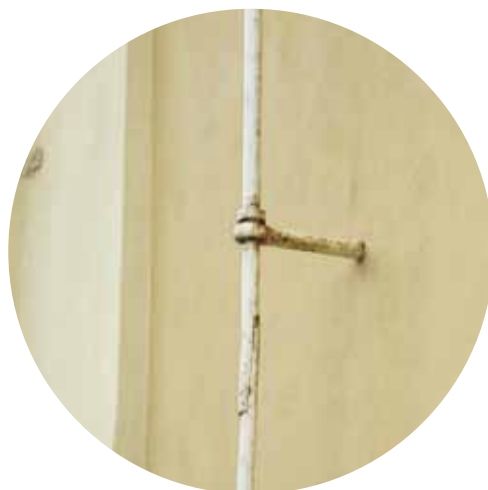
Фрагменты токоотвода (в Указе Екатерины II – «Электрического отвода») Lead fragments (in Ekaterina the Second's Decree – "Electric lead")
