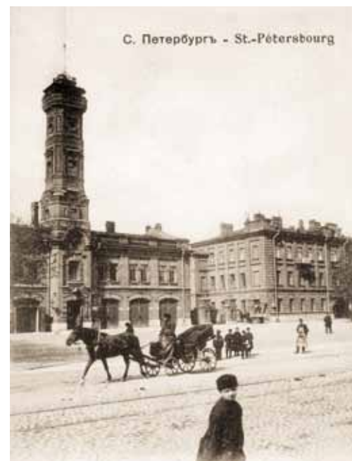
Васильевская пожарная часть Санкт-Петербургской пожарной команды. Почтовая карточка. Начало XX в.
