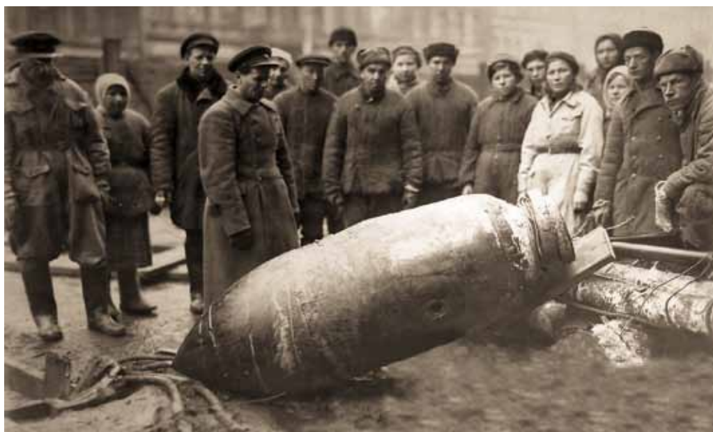
Группа бойцов-подрывников МПВО г. Ленинграда у немецкой бомбы, извлеченной из котлована 14 апреля 1943 г.
