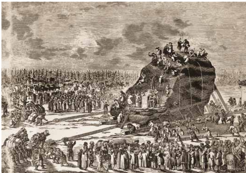
Вид Гром-камня во время перевозки его в присутствии Екатерины II 20 января 1770 г. Гравюра Я. Шлея по ориг. Ю.М. Фельтена. 1770-е гг. Гранитная глыба для постаменты памятника Петру I в Петербурге весом около 100 тыс. пудов была найдена в районе поселка Лахта на Карельском перешейке. Перевозка Гром-камня в Петербург осуществлялась в течение двух лет Grom-stone look at the time of its transportation at the presence of Ekaterina the Second on the 20th of January, 1770. The engraving by Ya. Shley according to original by Y. M. Felten. 1770-1780. A granite block for Peter the First' monument pedestal in Saint-Petersburg with weight about 100 000 poods was found in the area of Lahta settlement on Karelian isthmus. Grom-stone transportation to Saint-Petersburg carried out for two years
