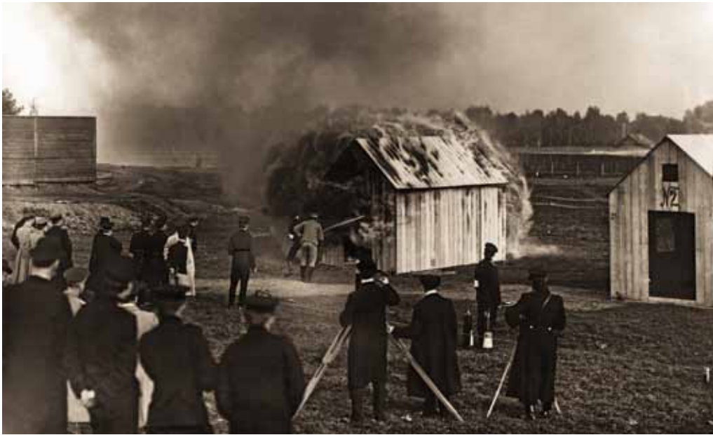
Испытание огнетушителей. Санкт-Петербург. 22 сентября 1909 г. Фото К. Булла Fire extinguishers test. Saint-Petersburg. The 22nd of September, 1909. A photo by K. Bulla
