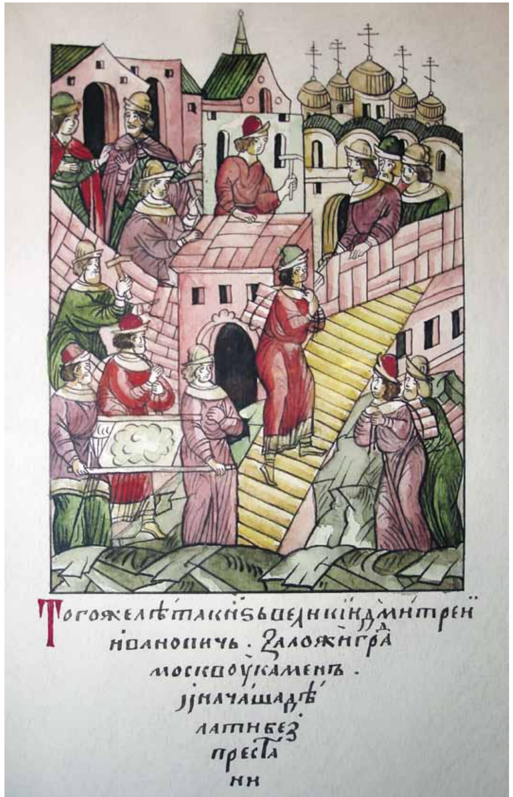
Строительство каменного Кремля в Москве. Лист из «Летописного лицевого свода». XV в. The stone Kremlin building in Moscow. A list of "Illuminated annalistic arch". The XV century
