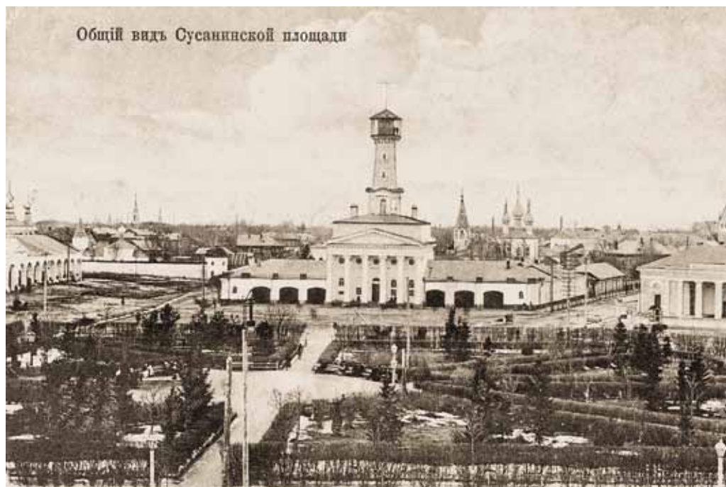
Пожарное депо г. Костромы (постройки 1826 г.)
