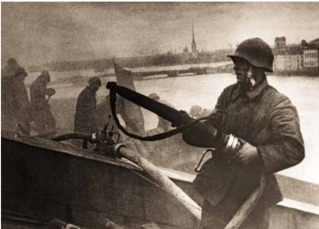
Тушение пожара в здании бывшего Сената. Ленинград. 18 октября 1941 г. A fire extinguishing in former Senate building. Leningrad. The 18th of October, 1941
