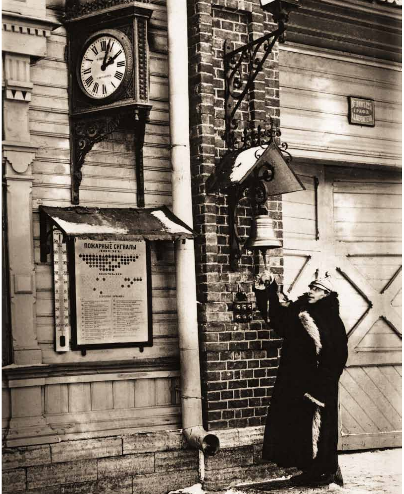
Часовой у малого колокола на фасаде Пожарного депо Ульяновской Пожарной Команды графа А.Д. Шереметева. Начало XX в. A sentry nearby small bell on count A. D. Sheremetev Ulianka Fire Brigade Fire station facade. The beginning of the XX century
