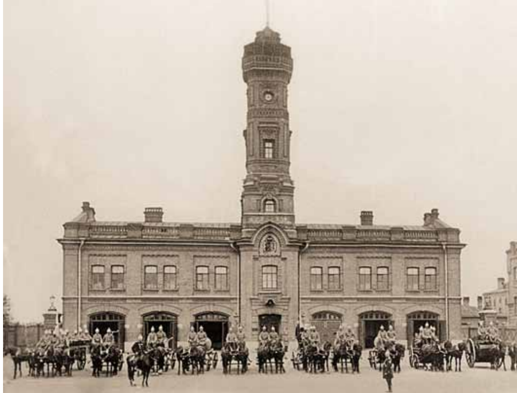
Васильевская пожарная часть Санкт-Петербургской Пожарной Команды. Начало XX в Saint-Petersburg Fire Brigade Vasilievskaya fire station. The beginning of the XX century
