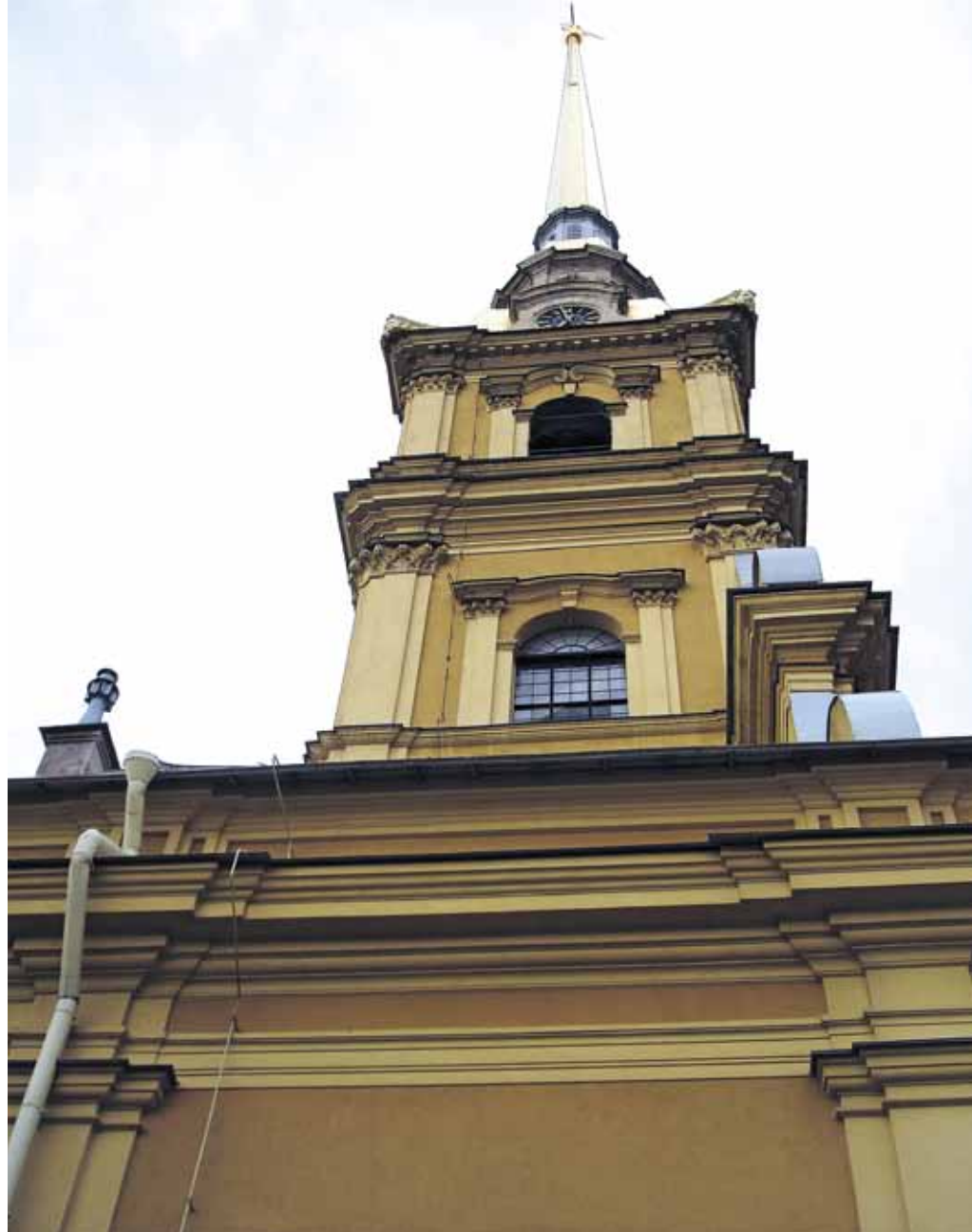
Колокольня Петропавловского Собора. На фотографии (в левой части) виден, проложенный по стене от шпиля к земле, металлический токоотвод (элемент молниезащиты шпиля), установленный по Указу Екатерины II
