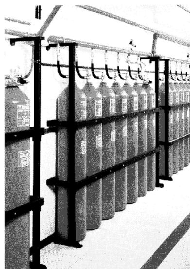
Батарея FE-13-пожаротушения (LPG, Испания).
