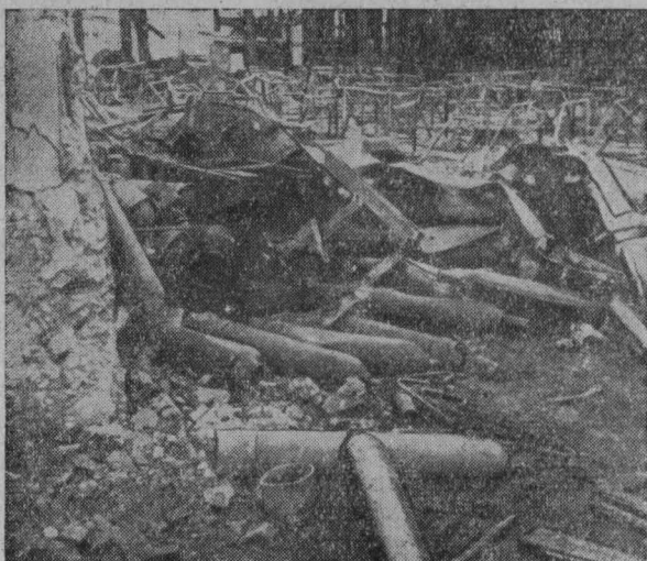
Рис. 121. Место складирования баллонов и разорвавшегося баллона с углекислым газом.
