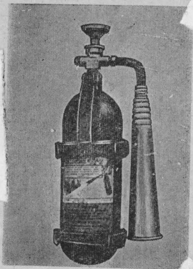
Рис. 8. Внешний вид огнетушителя ОУ-2.
