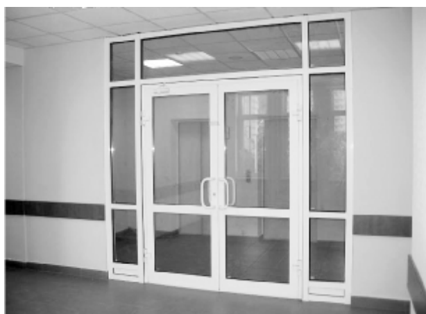
Рис. 11. Противопожарная светопрозрачная дверь производства ООО “Фототех” огнестойкостью EI 60
