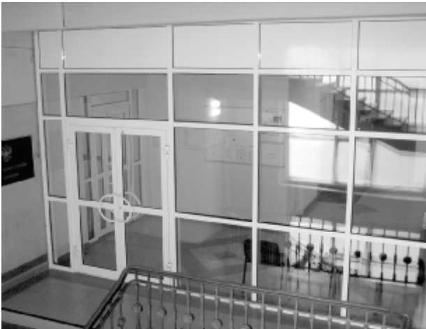
Рис. 2. Перегородка огнестойкая светопрозрачная типа ПСОМ-1-45. Предел огнестойкости — EI 45. Производитель — ООО “Фототех”
