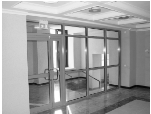
Рис. 3. Перегородка огнестойкая светопрозрачная типа ПСОМ-1-60. Предел огнестойкости — EI 60. Производитель — ООО “Фототех”
