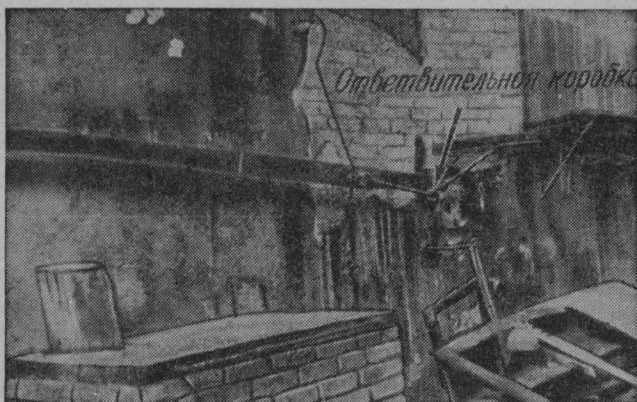
Рис. 3. Часть помещения, в котором возник пожар. Правее плиты обрушилась штукатурка, а полка сгорела в большей степени. На полу лежит обгоревшая крышка рабочего стола.
