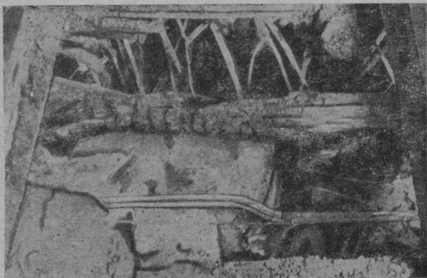
Рис. 28. Результаты загорания балки чердачного перекрытия, находившейся в контакте с перекрышей комнатной печи.
