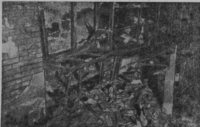
Рис. 37. На переднем плане сгоревшая часть прилавка, печь и наиболее выгоревший участок стеллажей отдела обуви. С удалением от этого места к центру торгового зала разрушения уменьшаются.
