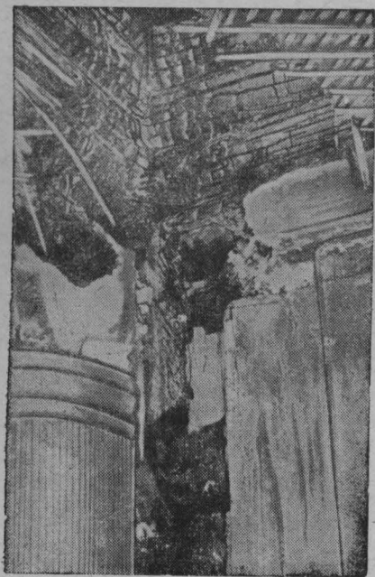
Рис. 4. Выгорание стен в пределах киноподъема и чердака над ней. Перекрытие киноподъема на этом участке также выгорело.
