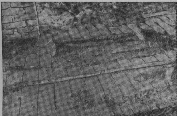
Рис. 19. Выгорание полов в коридоре и в чердачных карманах.
