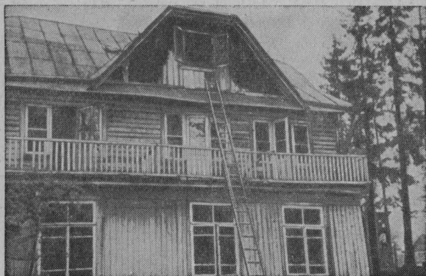
Рис. 17. Западная сторона дачи после пожара. Сгорела дощатая лестничная клетка, пристроенная с южной стороны дачи, частично выгорели мансардные помещения.
