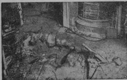
Рис. 46. Очаговые поражения после пожара от попавшего в перекрытие угля через щель в полу комнаты.
