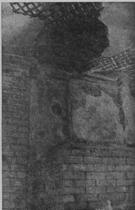
Рис. 40. Сосредоточенное разрушение перекрытия над печью, образовавшееся во время пожара и его тушения — один из признаков очага пожара, над местом его возникновения.
