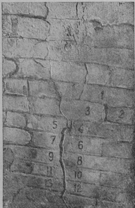
Рис. 42. Щели в кладке западной стенки печи. Светлые оттенки ее поверхности свидетельствуют о сильном местном нагреве.
