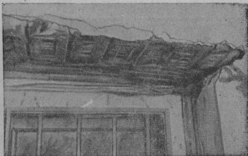
Рис. 24. Загорание оконной перемычки, конец которой оказался введенным в дымоход производственного сушила.
