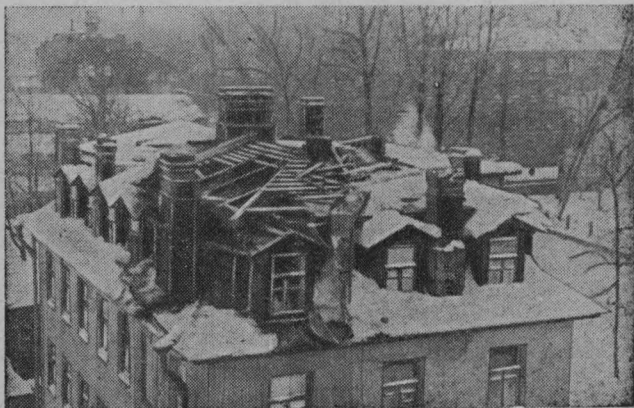
Рис. 11. Последствие пожара, возникшего в мансардной части жилого дома в результате недобросовестной работы печника при устройстве патрубка.
