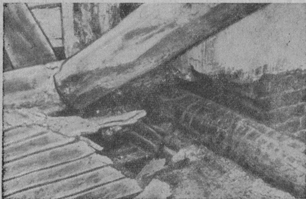
Рис. 25. Балка чердачного перекрытия в месте ее ввода в вентиляционный канал обгорела в наибольшей степени.
