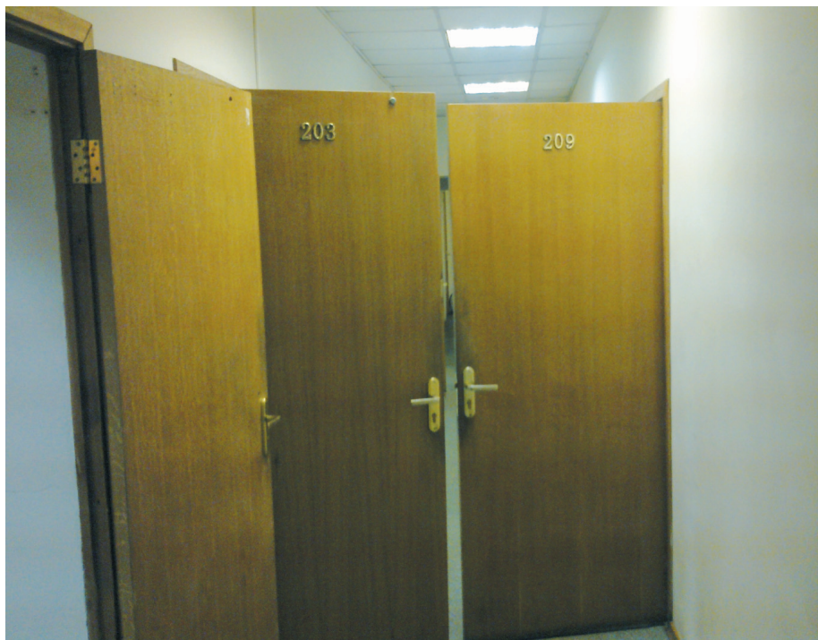
Рис. 6.7. Вид коридора с открытыми дверями из помещений
