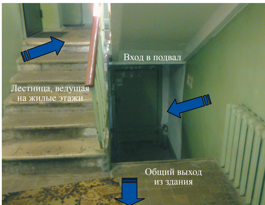
Рис. 6.27. Выход из подвала не обособлен от вышележащих этажей
