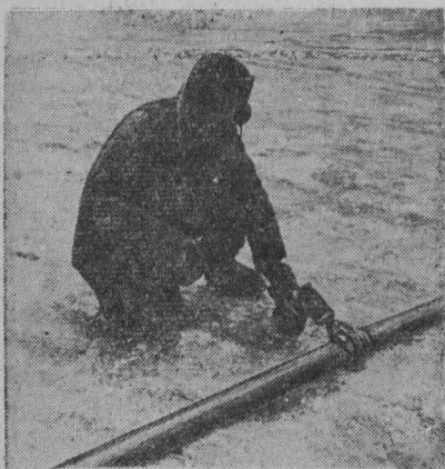
Рис. 40. Отогревание замерзшего рукавного соединения применением паяльной лампы.
