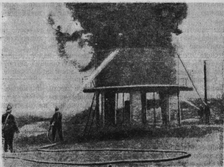
Фиг. 120. Подача пенного накидного ствола и двух струй воды для охлаждения резервуара.
