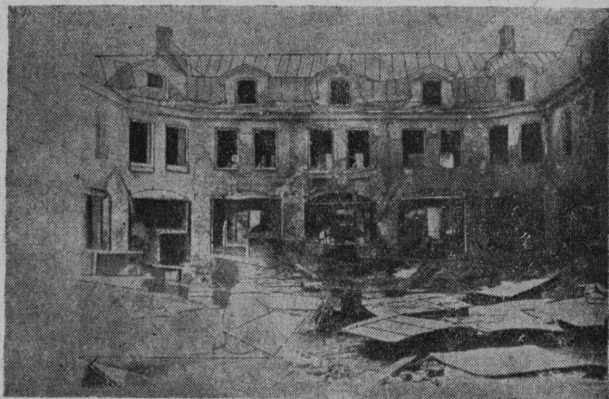
Фиг. 144. Результаты пожара в каменном здании. Огонь распространился по вентиляционным каналам.
